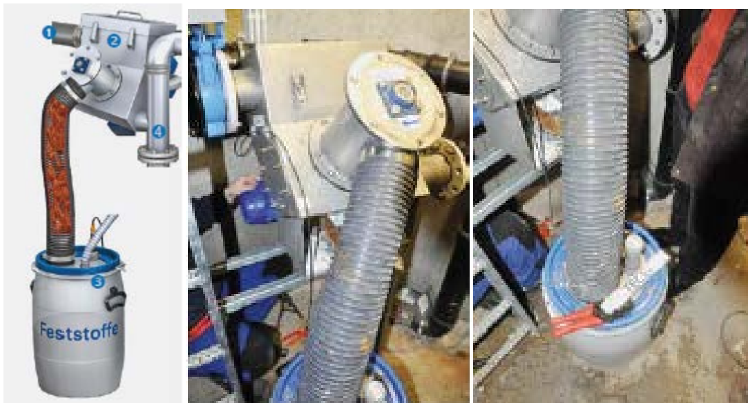
Abbildung 2: Eingesetzter Separator zur Abscheidung der Feststoffe aus dem Abwasserstrom mit Auffangbehälter. 1: Einlauf, 2: Abscheider mit Förderschnecke, 3: Sammelfass, 4: Auslass (TECE/Basika)
